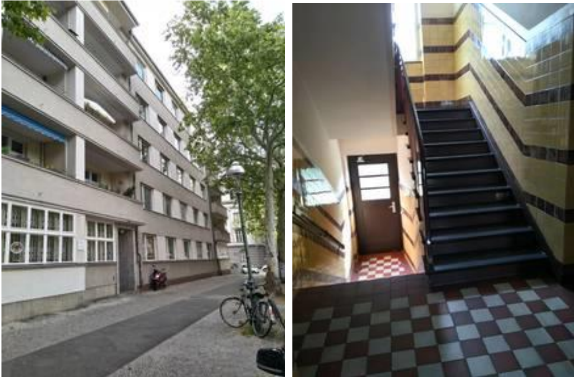
(BVG Häuser in der Soorstraße/Hausaufgang in der Soorstraße, Fotos: Marianne Mielke)
